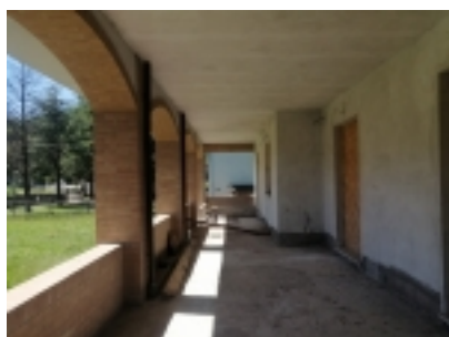
ingresso piano terra
