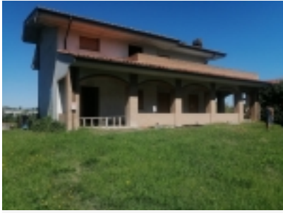
villetta in costruzione
