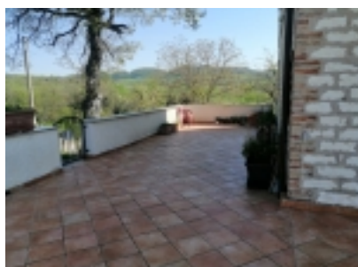
lastrico solare piastrellato
