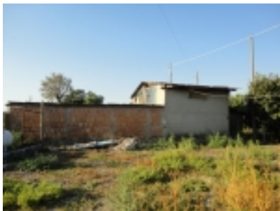
Magazzino e tettoia
